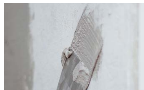
Bei Bauarbeiten: Verputzen, Spachteln.
