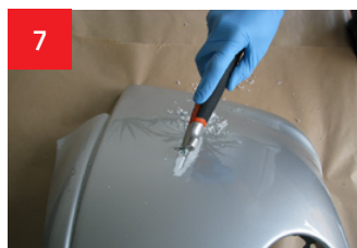
7 Couper la fissure en « V », décaper, souffler.
