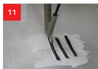
11 Renforcer la zone réparée, et pour cela souder quelques fragments du fil de soudage du côté intérieur perpendiculairement à la fissure.
