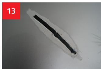
13 Après le refroidissement, rectifier, dégraisser, souffler, mastiquer, traiter, peindre.
