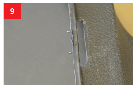
9 Il faut poncer des extrémités faisant saillie après le découpage (par exemple, avec la ponceuse APP no 139102).
