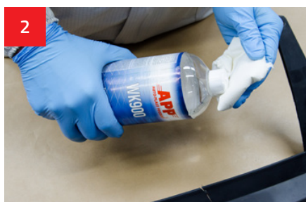
2 Avant de commencer la réparation, décaper et dégraisser la surface à traiter avec WK900.
