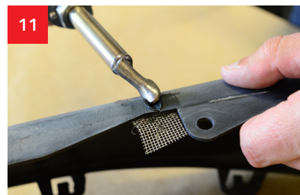
11 Po zewnętrznej stronie uszkodzenia przygotowujemy miejsce na wtopienie spoiwa.
