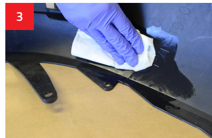
Czyszczenie oraz odtłuszczenie miejsca naprawy za pomocą WK900 po obu stronach uszkodzenia.
